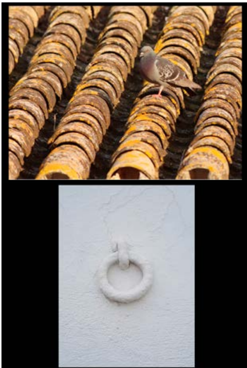
Arriba, tejas tradicionales de barro. Abajo, argolla que se situaba en los lados de las puertas para amarrar a las bestias.
