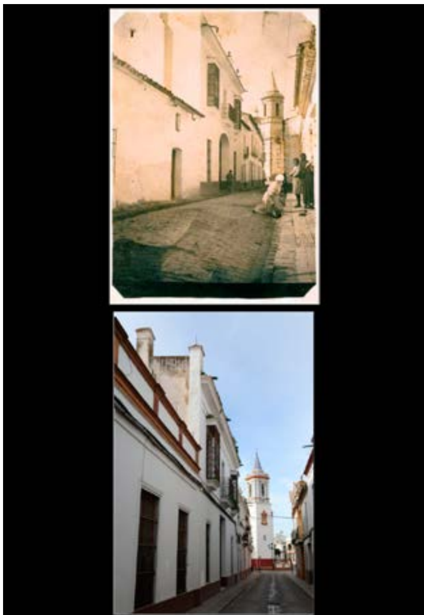
La iglesia de Santa María la Mayor, en distintos períodos (abajo en la actualidad). La casa de los balcones de reja es la Casa de Juanito Rosa (Juan de la Rosa), una de las pocas casas señoriales que quedan en Pilas.
