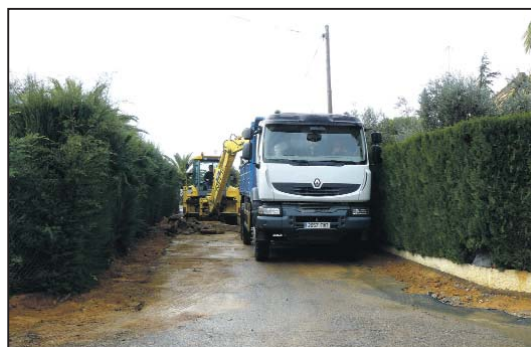
Maquinaria en plena faena en la urbanización El Rosal
