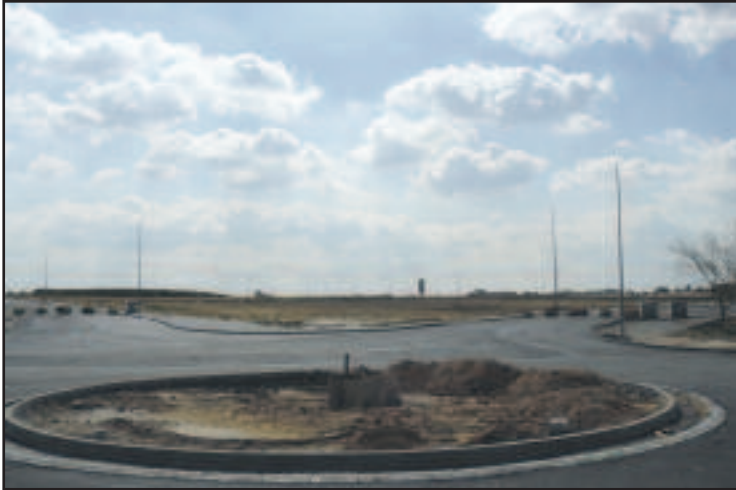
Las obras de la ampliación del P.I. Gandul marchan en los plazos previstos
