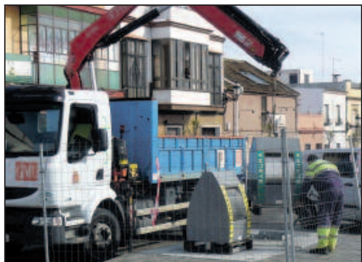
Operarios municipales ultimando la instalación de los buzones
