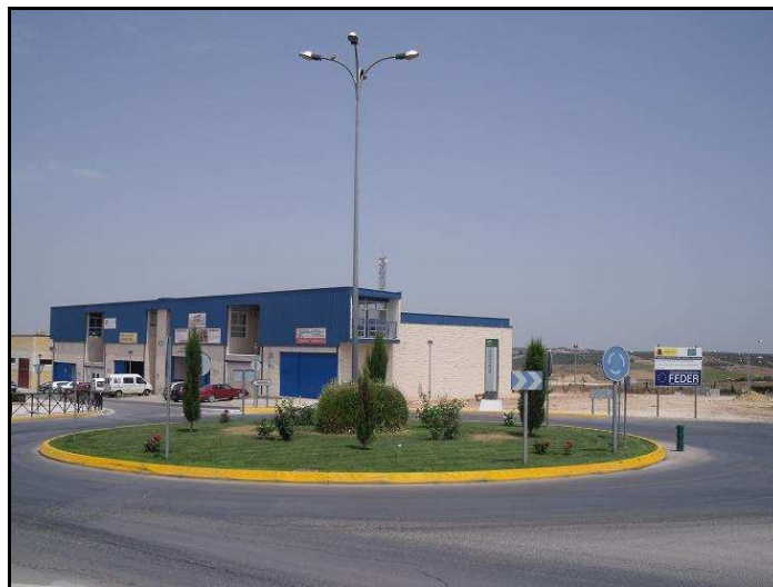
Fotografía 39. Rotonda carretera Puente Genil.
