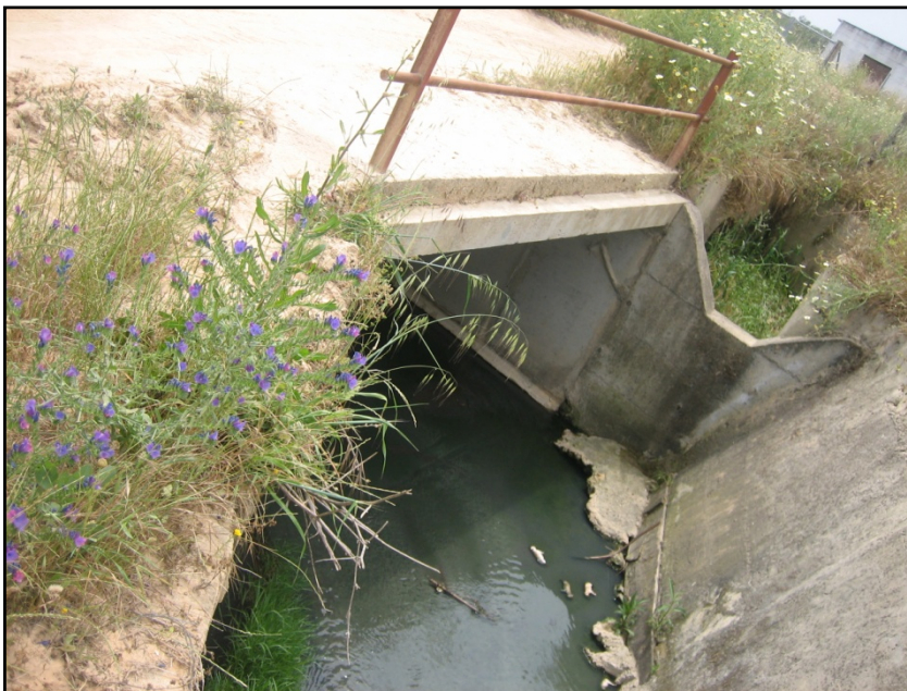
Vista del Paso N° 2 del Arroyo Sequillo.
