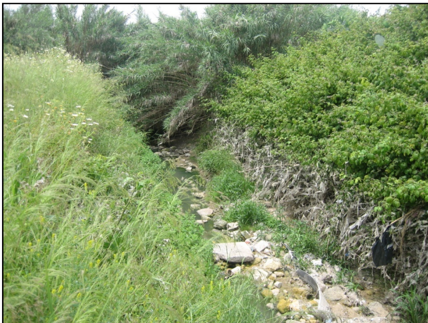
Vista del Cauce de Arroyo Almargen a su salida del entubamiento.
