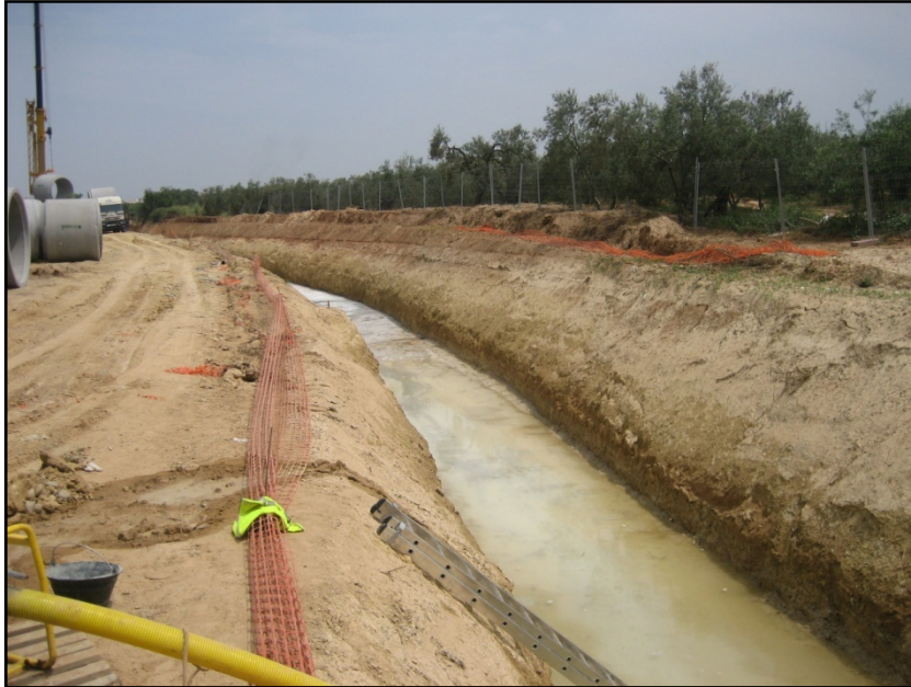
Vista de las obras del nuevo tramo entubamiento del arroyo Almargen.
