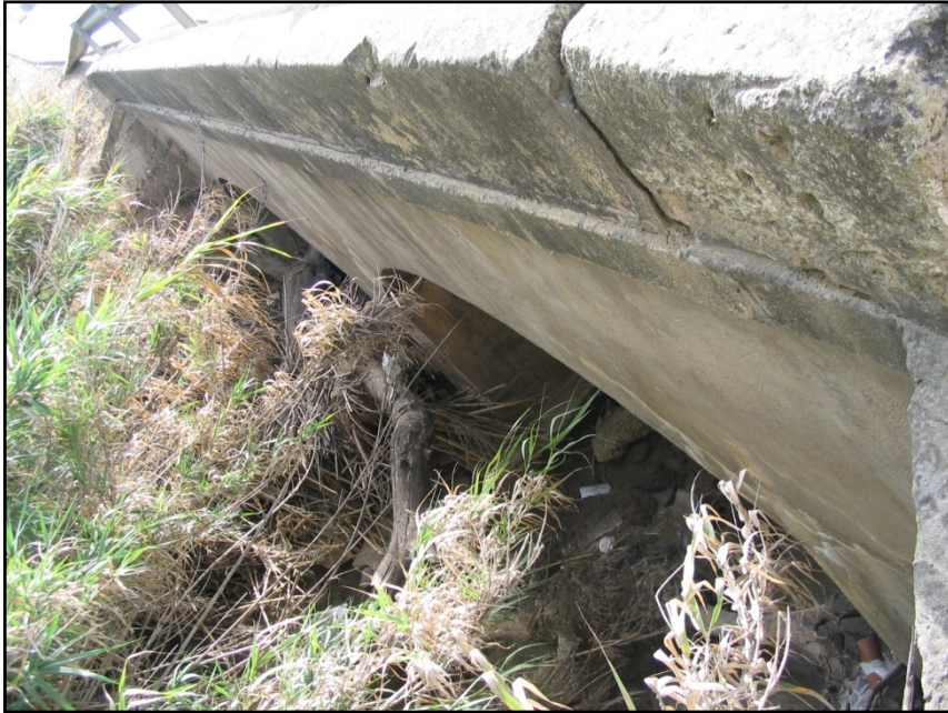
Vista del Paso sobre la A-474 del río Pudío
