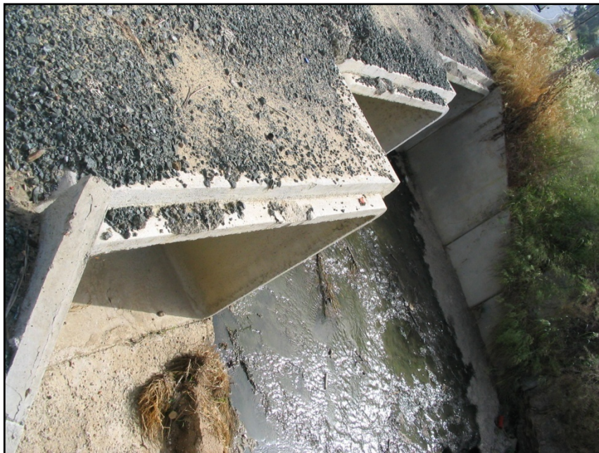
Vista del Paso Nº 1 del Arroyo Sequillo, paso bajo la carretera A-474.
