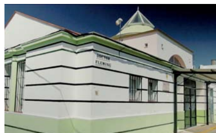
◉ Mejora y adecuación del antiguo consultorio. 40.000 euros. 3 puestos de trabajo
