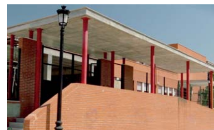
◉ Rampa de acceso al Colegio. 42.000 euros. 3 puestos de trabajo
