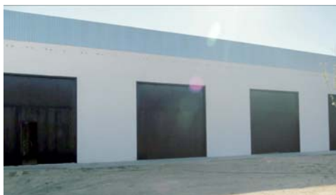
◉ Edificio Creación Centro de Empresas. 290.000 euros. Junta de Andalucía e INEM.
