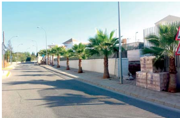
◉ Acceso y ajardinamiento de nueva guardería. PFOEA: 97.981 euros 28 puestos de trabajo.
