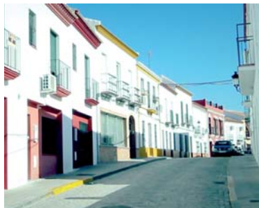
◉ Calle Campanas y Calle Corralejas Aljarafe: 444.791 euros. Mejora del saneamiento
