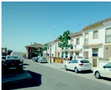
◉ Pavimentación y mejora de Calle Ventorro. P.E.E: 100.795 euros. 72 puestos de trabajo.
