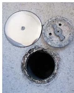
10. Bote sifónico con tapa desmontada.
